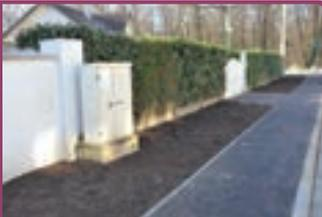
Gounod, route Royale, allée des Charmes et bois de l'Érable. Dans l'avenue Saint-Exupéry (photo ci-dessus), la technique utilisée tend à limiter le rejet immédiat des eaux pluviales dans le réseau en les dirigeant d'abord vers la zone engazonnée longeant le trottoir. Seul le surplus non absorbé par le terrain naturel se retrouve dans le réseau, évitant ainsi de saturer les réseaux d'eaux pluviales.
