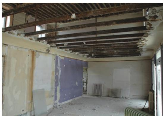
Un nouveau plancher sera posé, à partir du mois d'octobre. Les normes d'habitation exigent en effet une structure supportant au minimum une charge de 350 kg/m<sup>2</sup> alors que le plancher actuel admet seulement 150 kg/m<sup>2</sup>. Il s'agit donc d'une obligation avant toute restructuration intérieure. De plus, un dossier de subvention va être déposé auprès du Conseil Général dans le cadre de la mise en accessibilité du site aux personnes en situation de handicap.
