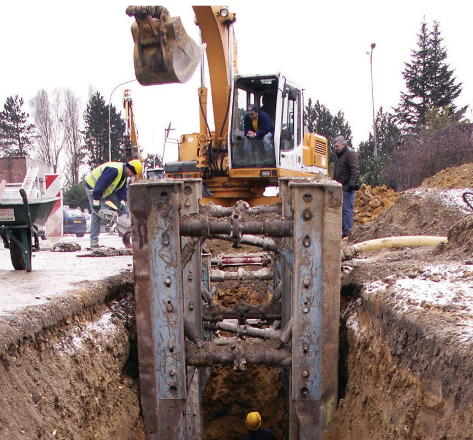
Les travaux d'assainissement de l'avenue Robert Schumann
