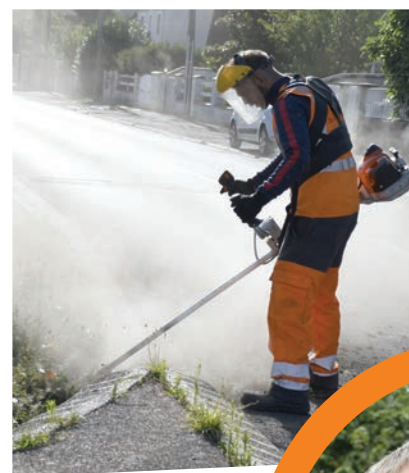
Le binage de la végétation spontanée sur la voirie est réalisé de façon mécanique, c'est-à-dire des débroussailluses mosquito et sans recours à de produits phytosanitaires. Un travail de fourmi qui répond aux exigences de préservation de l'environnement.
