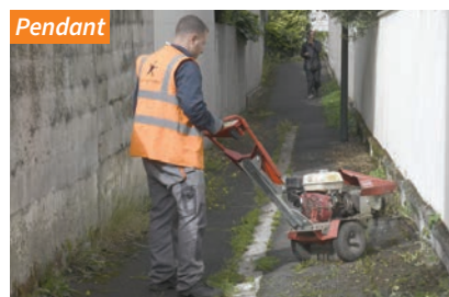
Le binage de la végétation spontanée sur la voirie est réalisé de façon mécanique, c'est-à-dire des débroussailluses mosquito et sans recours à de produits phytosanitaires. Un travail de fourmi qui répond aux exigences de préservation de l'environnement.
