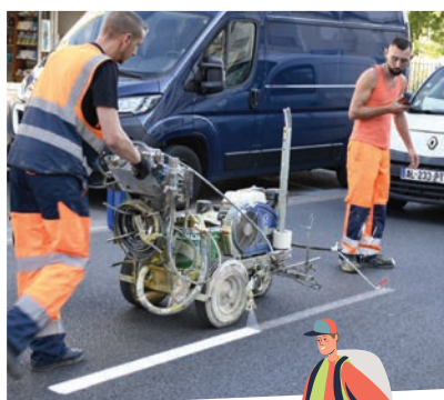
La signalisation horizontale a fait l'objet d'une campagne importante cet été. Un calendrier d'intervention partagé avec un prestataire qui prend en charge le traçage des bandes axiales, tandis que le service voirie se concentre sur les passages piétons.
