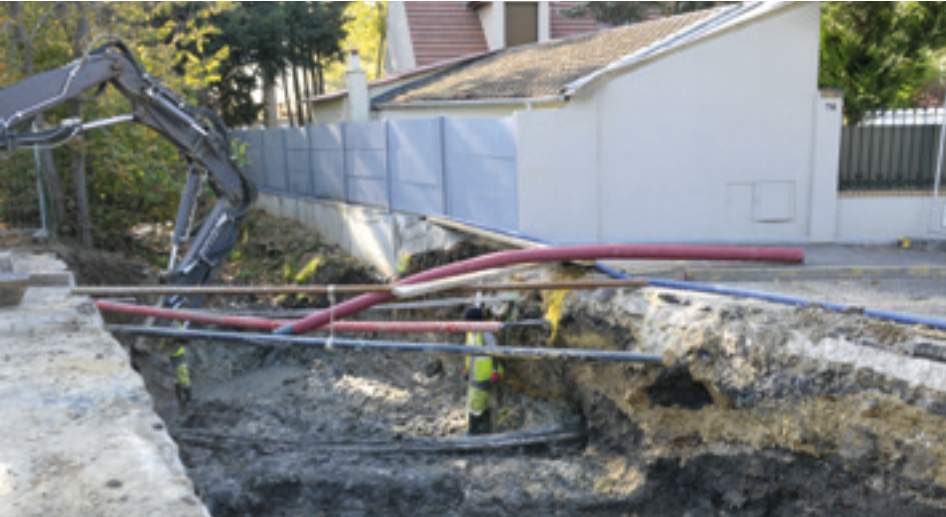
Avenue Rond Buisson : remplacement du conduit rigide par 6 canalisations rectangulaires côte à côte
