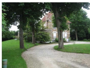
Maison détruite qui aurait pu être un cabinet Médical, comme le souhaitait l'ancien Maire (la surface du terrain sera bétonnée sur 2 niveaux)
